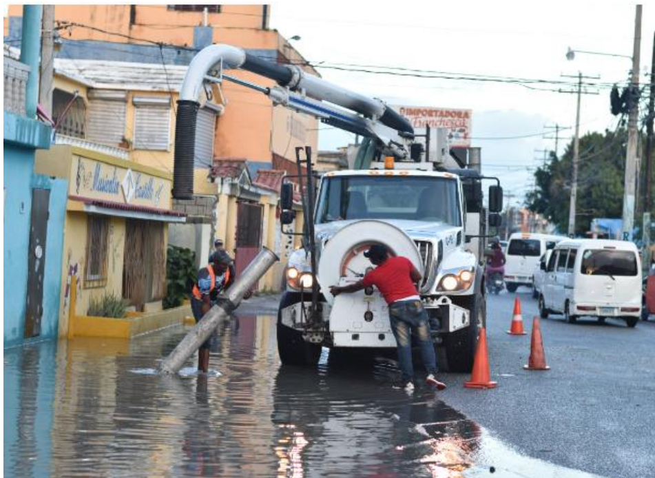
Figura 1. Trabajos realizados con el camión Hidrosuccionador
